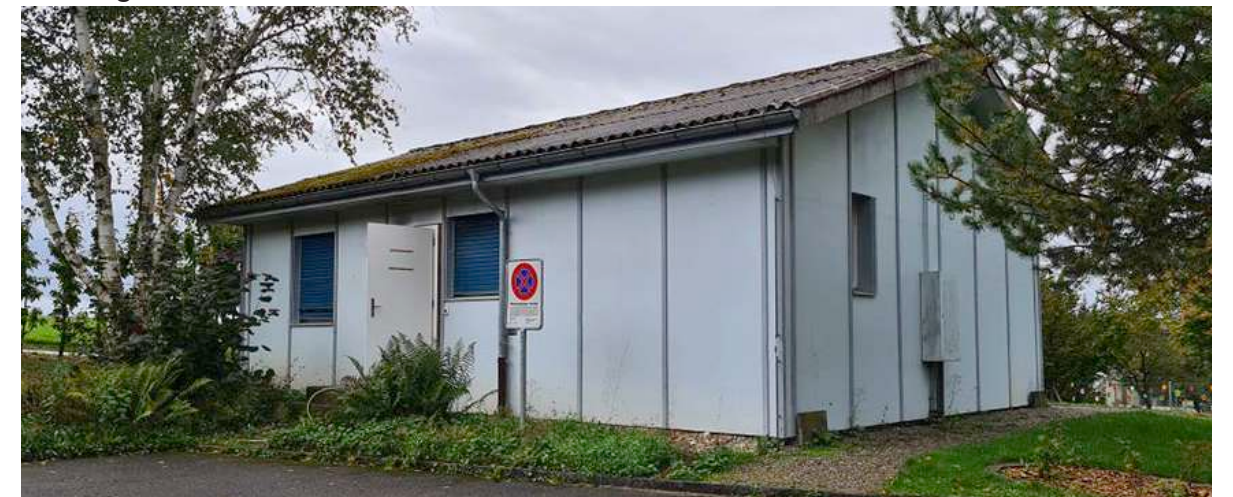
Pavillon wurde seit 2011 als ergänzender Schulraum benutzt. Seit Herbst 2022 nicht mehr in Betrieb. Ein Ersatzneubau ist bewilligt und wird 2024/25 erstellt.
