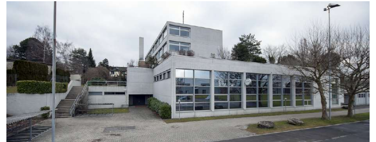
Das Schulhaus wurde 1972 - 1973 von Bieler Architekten Hansruedi Lanz erbaut
