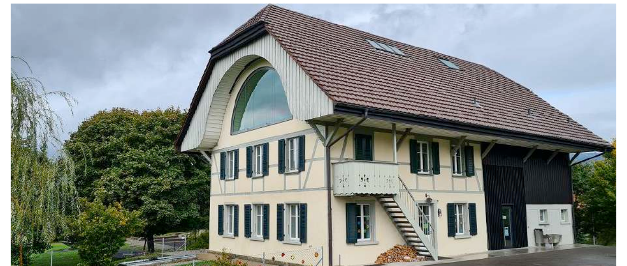
2011 - 2014 Umbau des alten „Lehrerhauses von 1937“ in die Tagesschule und Kindergarten
